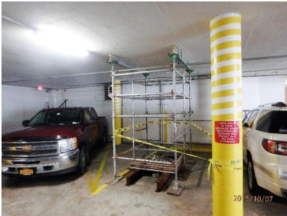
**FIGURE 3: SHORING UNDER LIFT**
